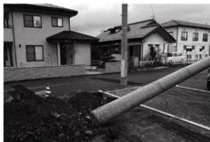
1 施工状況（南東から）
