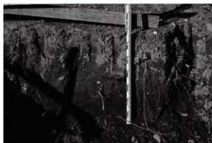
2 基礎掘削断面
