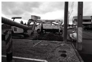
2 施工状況（北から）
