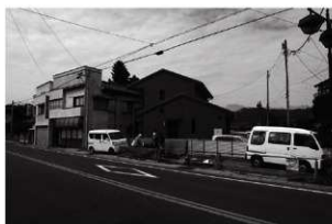
2 調査状況 (北東から)
