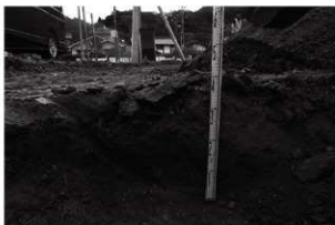
2 基礎掘削東壁
