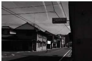
2 国道19号線（調査地から北）
