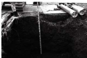
2 上下水道引き込み部東壁
