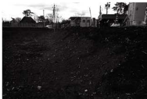
3 切土（北西から）
