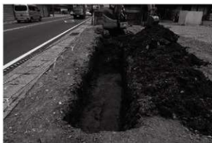
5 完掘状況（南から）
