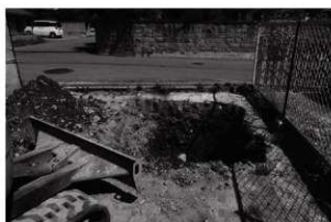
7 Cトレンチ完掘（南から）
