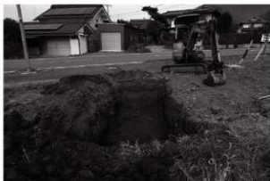
4 トレンチ完掘 (南から)
