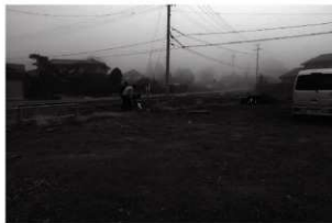
1 調査地近景 (南西から)
