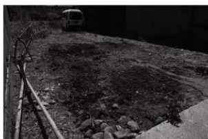
8 埋戻し後（北西から）
