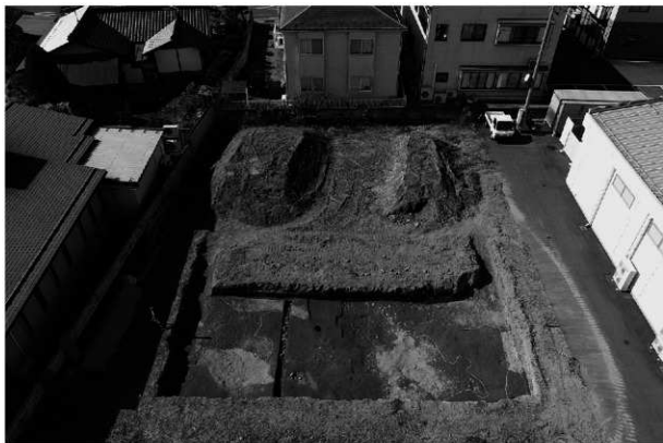
1 調査区全景（上が西）
