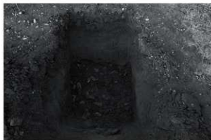
8 掘削底面確認状況（南から）
