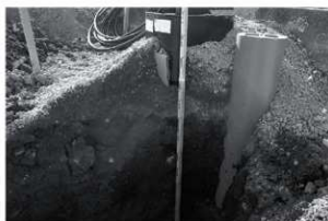
5 C地点調査状況（北東から）
