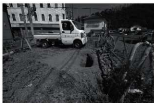
4 完掘状況 (西から)
