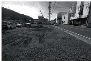
8 埋戻し状況（北から）
