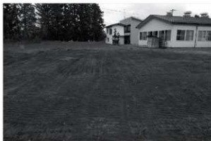
7 埋戻し状況 (西から)
