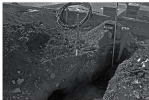
4 C地点調査状況（北東から）
