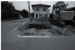
5 完掘状況（西から）
