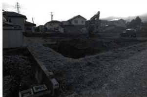
5 完掘状況遠景（北東から）
