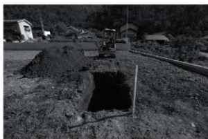
4 完掘状況（西から）
