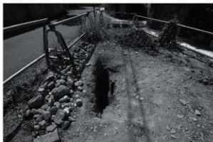
5 完掘状況 (東から)
