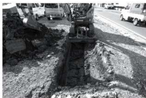
3 完掘状況（北から）
