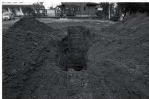
5 完掘状況 (東から)
