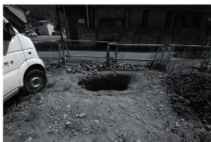
3 完掘状況 (北から)
