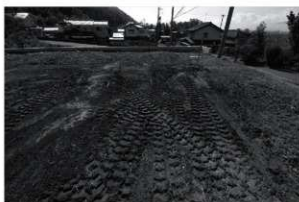
7 埋戻し状況（北から）
