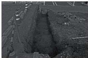
5 SI1 検出状況（西から）
