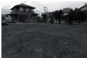
8 埋戻し状況 (南東から)
