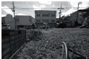
3 調査前（西から）
