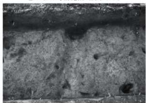
③ A区2号溝完掘 (東から)
