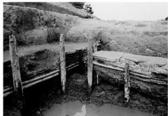
③D-1護岸柵列
