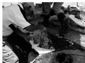
写真10 脱型作業状況
