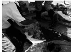
写真10 脱型作業状況
