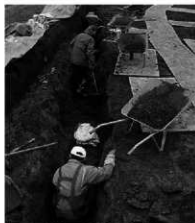
⑧ B区調査風景
