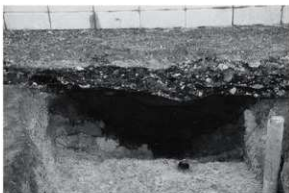
⑤ 5号土坑土層断面(北から)
