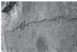
④2号溝完掘状況 (南から)
