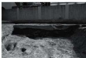
④ 5号溝 B-B' ベルト土層断面 (北側から)
