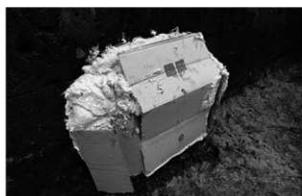
⑦発泡ウレタン注入状況
