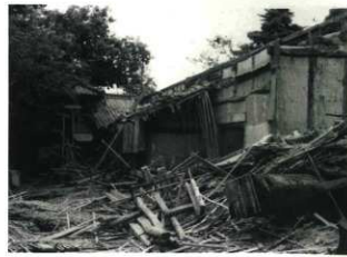
写真43 解体される南のくら(昭和41年)
