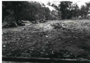
写真10 雨のくら解体後の様子(昭和41年頃)
