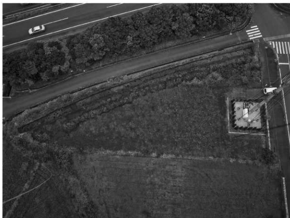
2. B区全景（上空から）
