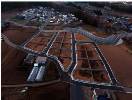
向陽台団地第3期造成竣工写真（北東より）
