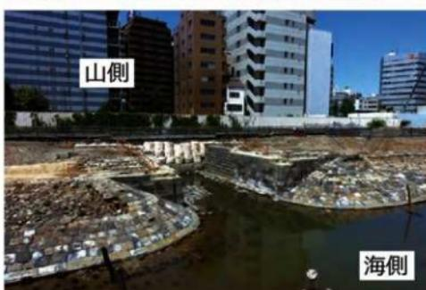
図0-11 この橋梁部では、石材をレンガのように整形して積み、目地材を使って接着している様子も見ることができる。西洋の考えが取り入れられていると考えられる。
