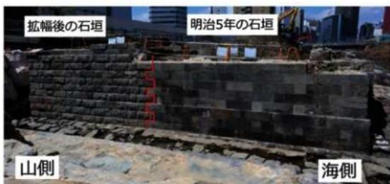
図0-12 石垣の表面を見ると、写真奥（山側）と手前（海側）で仕上げが違うことが確認できる。橋台が山側に拡幅されたことがわかる。
