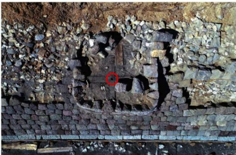
図4-15 張り出し造構内部十字組基礎（4街区、上から）
