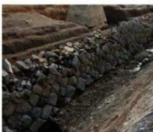
図0-20 拡張後 山側（西）石垣（谷積み）
