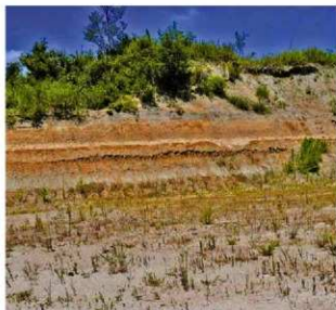
図3 茨城県東海村中丸地内の露頭
