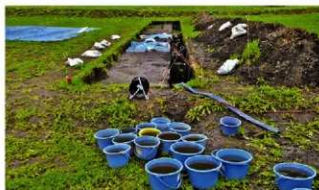
1. 第32トレンチの排水(7月3日)
