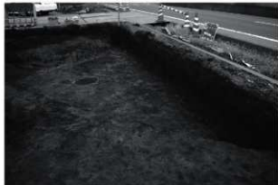
写真 197 S11 掘削状況 (北東から)
