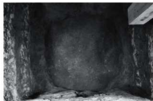
写真 177 諸役会所床下陥没箇所掘削状況（東から）
