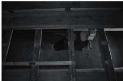
写真 174 諸役会所床下陥没箇所 (東から)
