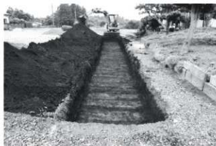
写真84 トレンチ掘削状況(東から)
