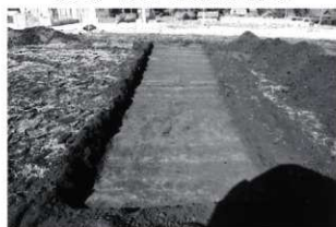
写真 162 トレンチ4 掘削状況 (南から)
