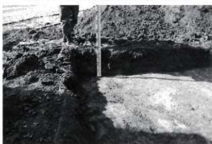
写真 161 トレンチ3 掘削深度 (東から)
