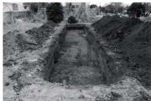
写真 154 トレンチ2 掘削状況 (西から)
