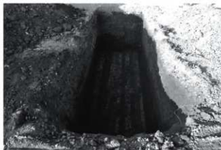
写真59 トレンチ3掘削状況(南から)
