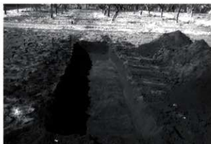
写真 149 トレンチ 1 掘削状況 (東から)
