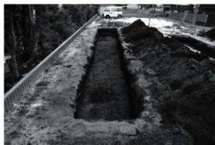
写真15 トレンチ1掘削状況(西から)
