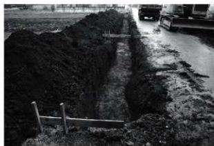
写真 17 トレンチ1掘削状況（東から）
