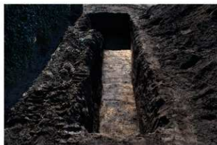
写真 73 トレンチ 3 掘削状況（北から）
