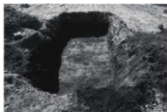
写真133 トレンチ掘削状況（東から）
