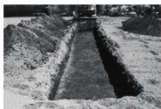
写真 131 トレンチ 1 掘削状況（西から）
