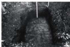
写真 148 トレンチ3掘削深度(西から)
