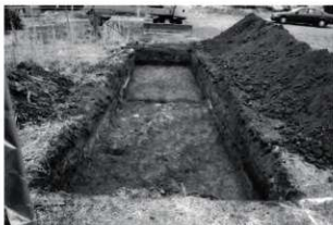
写真 155 トレンチ3 掘削状況 (北から)
