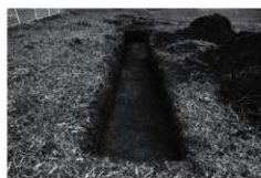
写真8 トレンチ1掘削状況（南西から）
