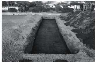
写真 107 トレンチ 3 掘削状況 (南から)
