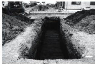
写真47 トレンチ1 掘削状況（東から）
