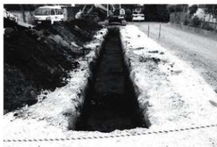
写真45 トレンチ掘削状況（西から）
