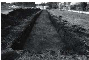
写真6 トレンチ2 掘削状況 (南から)
