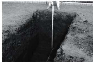
写真 53 トレンチ 1 溝跡検出深度 (南西から)
