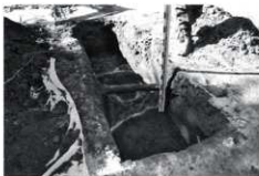
写真 145 トレンチ 1 掘削深度・遺構検出状況 (南東から)
