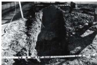
写真 83 トレンチ 1 掘削状況（西から）
