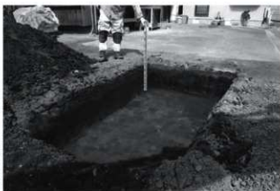
写真56 トレンチ1掘削深度（南東から）
