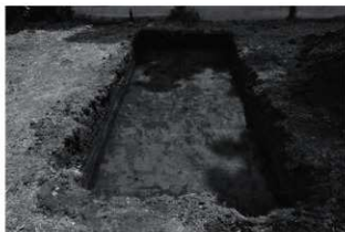
写真 35 トレンチ 2 掘削状況 (北東から)
