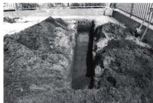
写真123 竪穴建物跡検出状況（南から）
