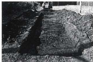
写真 167 トレンチ 1 掘削状況 (南東から)
