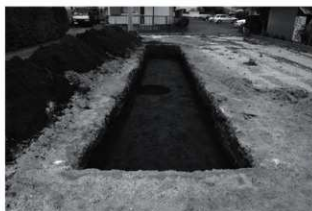
写真16 トレンチ2掘削状況(東から)
