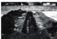
写真138 Dトレンチ掘削状況(南東から)
