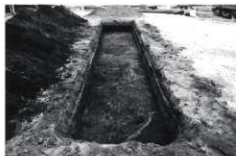
写真139 Eトレンチ掘削状況（南東から）
