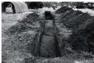
写真 152 トレンチ 1 掘削状況 (西から)
