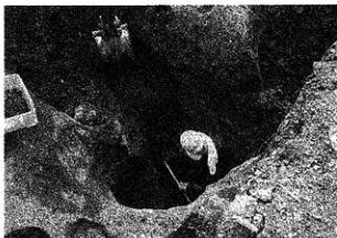
写真20 深掘りの状況 (北西から)
