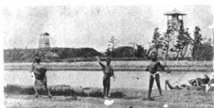
第24図 旧堺港北台場跡と陽明台
