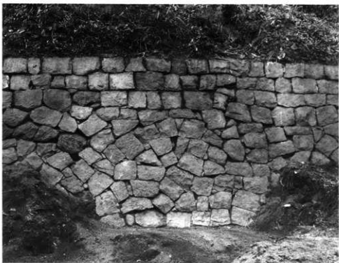
石垣検出状況
