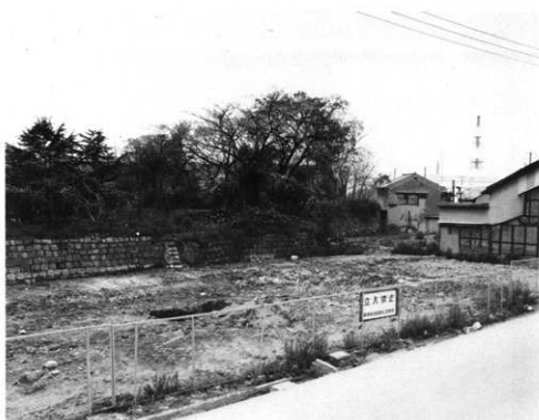
南台場東側石垣
