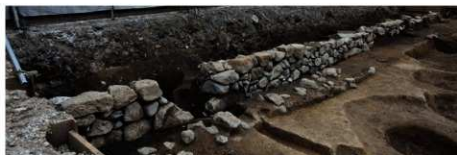
石組1西側(南東から)
