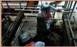
一本石垣解体
