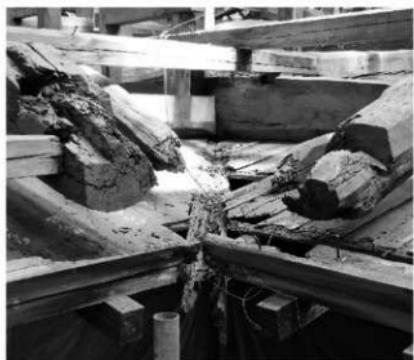
57 解体 谷部の小屋材の腐朽
