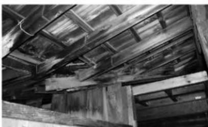
42 修理前 背面軒内部の腐朽
