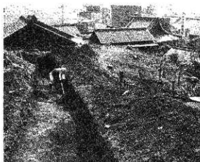
A区調査風景(北から)
