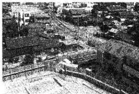
古鳴海停車場線遠景(第5次調査現在)
