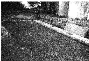
堀跡：SD-1-7南端付近(北東から)
