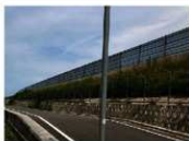
C. 東九州自動車道 擁壁/フェンス/植栽
