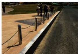
図8-2-2 車両等の進入を制限する欄 (吉武高木遺跡/福岡市)
