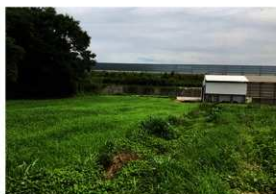
図 4-2-2 史跡指定地内を走る東九州自動車道 (北側から)
