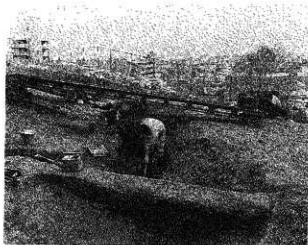
調査風景 (5-SD06の掘削)
