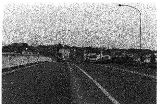
1次調査時遠景(天白橋より)
