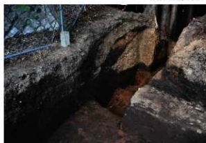
SA01 構築状況 (南から)
