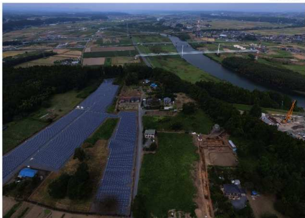
長者山城跡 全景（南上空から那珂川上流を望む）
