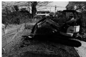
作ヶ谷津庚申塚トレンチ掘削状況
