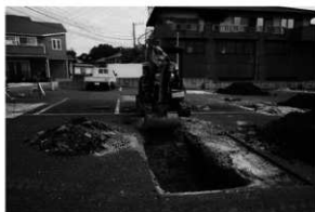
殿内遺跡 i 地点トレンチ掘削状況
