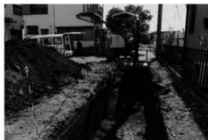
内込遺跡 f 地点トレンチ掘削状況
