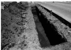
吉橋新山遺跡 b 地点 6T 完掘状況
