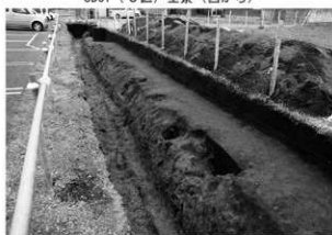
SD01 (3区) 近景 (北西から)
