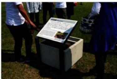
図 4.15 垣ノ島遺跡の解説板は地中に基礎を打たず、解説グッズ収納を兼ねたコンクリート柱で固定されています
