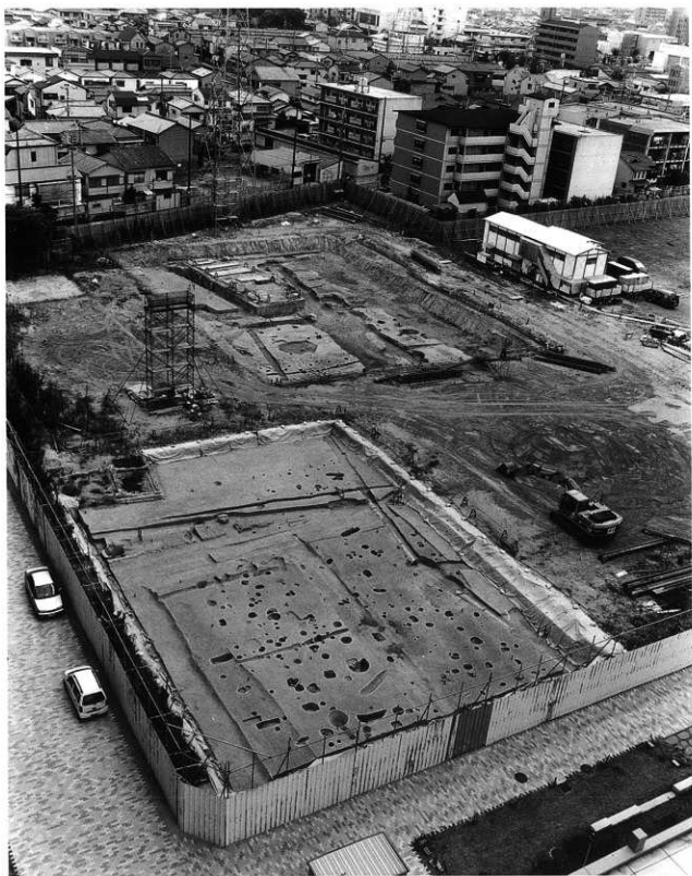
調査地全景(手前:02-1区第2面,中央:02-2区第2面)(北西から)
