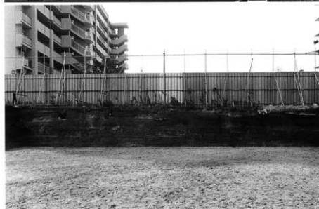
西側セクション(東から)
