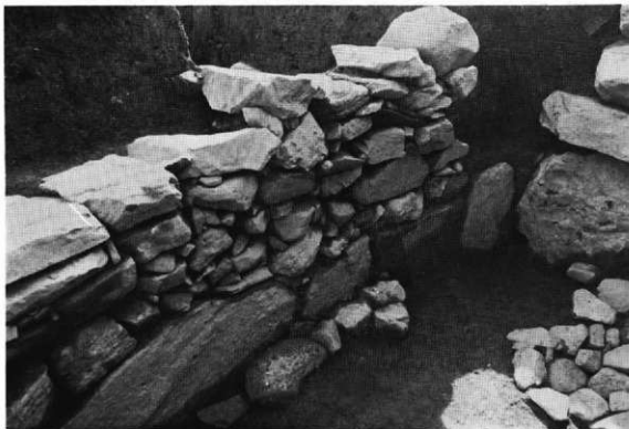
同右側壁石積状態
