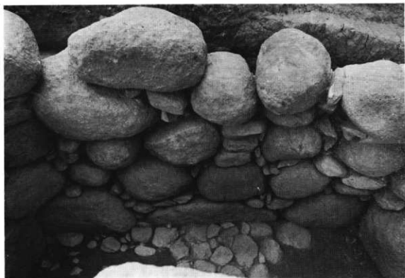
同後室右側壁石積状態
