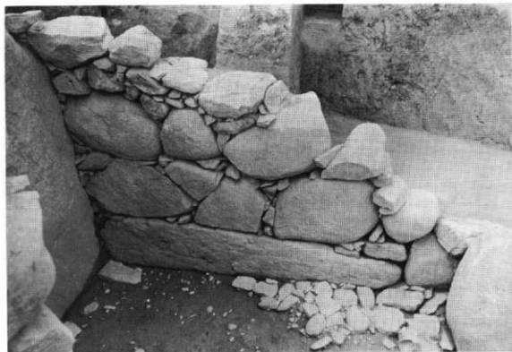
同後室右側壁石積状態
