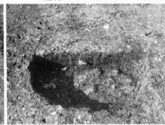
建物514 484ビット 南から
