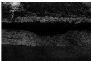
第6トレンチ内セクション（A-B，北から）
