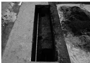
11区完掘状態（東より）
