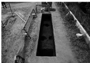
9区完掘状態(東より)
