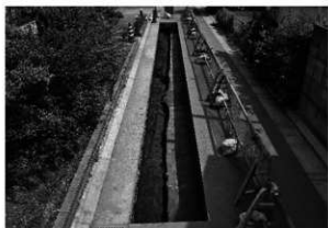
7区完掘状態（北西より）
