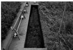
1区完掘状態 (南より)
