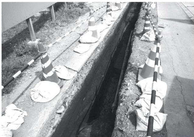
3号満土層断面および完掘状況(北より)
