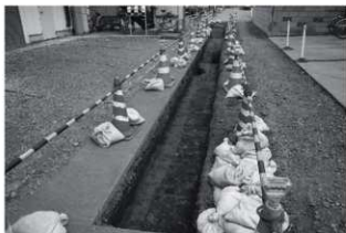
B区北側完掘状況（南より）
