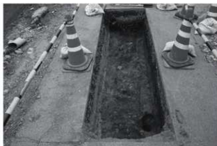
B区南側完掘状況（北より）
