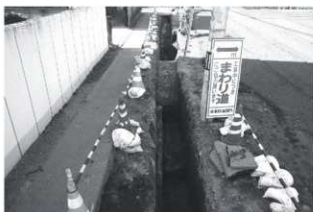
C区完掘状況（南より）
