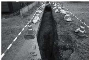
A区完掘状況③(南より)
