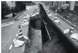
A区完掘状況②（北より）
