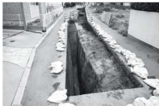
A区完掘状況①（北より）
