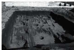
写真 24 調査区完掘状況 (西から)
