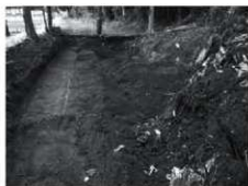
写真 14 トレンチ 3 堀跡検出状況 (東から)
