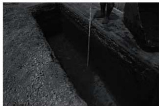
写真 19 5区溝跡検出状況（南東から）
