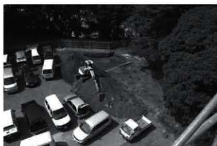
写真 32 トレンチ1 遠景(南から)
