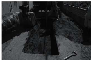
写真 18 1区掘削状況（西から）
