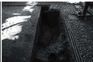
写真 39 2号遺構完掘状況(南から)
