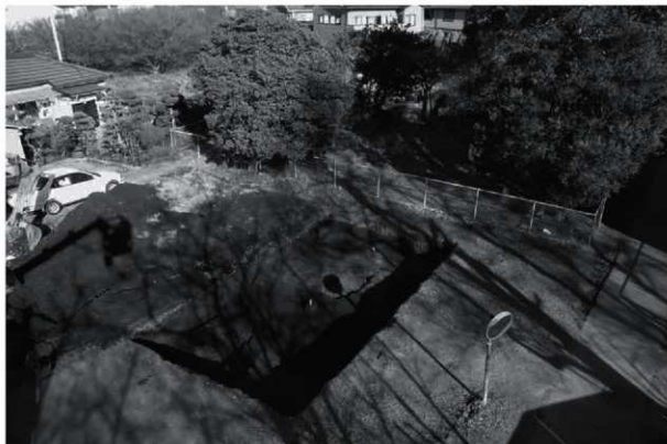
トレンチ遠景（西から）
