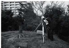
挿図写真1 測量調査風景
