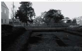
周溝検出状況 (東から)
