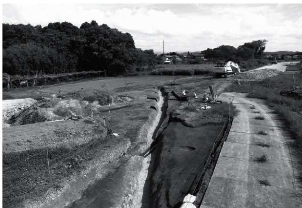
1号溝全景（南西から）
