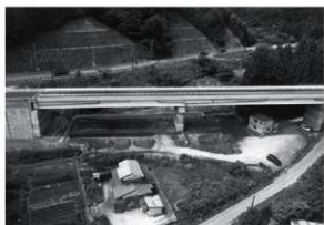
調査区全景（東上空から）
