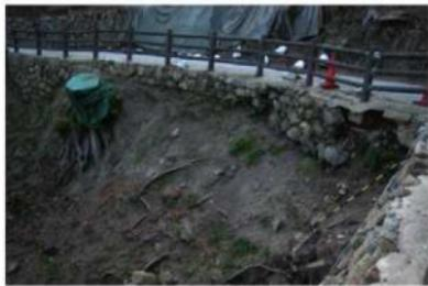
写真1 通路側面石積の毀損状況
