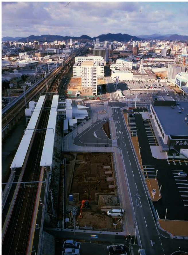
写真18 第18次 調査区近景(東から)
