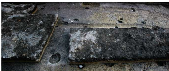
写真19 2区 SB3(北から)
