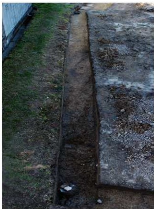
写真4 1区 南部(南から)
